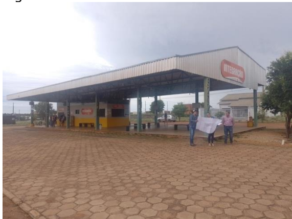
Figura1- Fachada do Terminal
