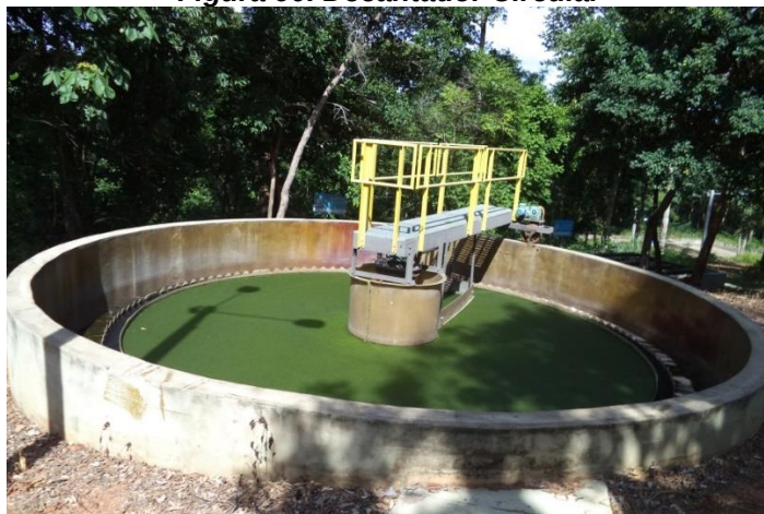
Figura 90. Decantador Circular
