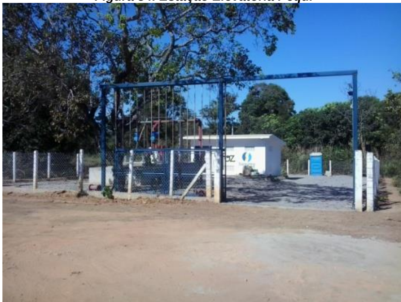
Figura 84. Estação Elevatória Pequii
