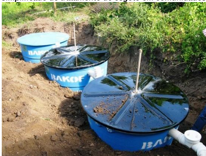
Figura 26. Modelo simplificado de tratamento de esgoto em comunidades rurais (EMBRAPA)
