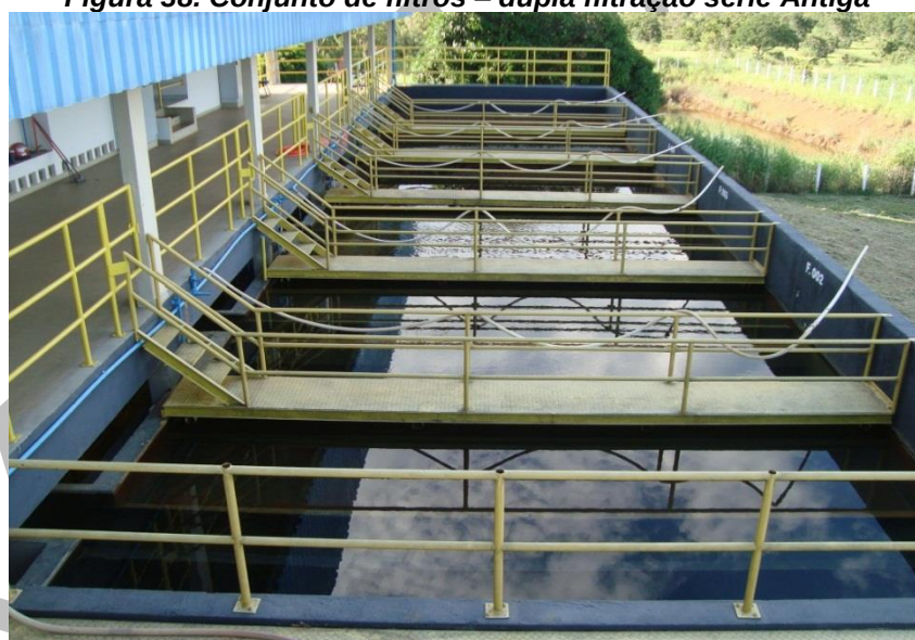
Figura 38. Conjunto de filtros – dupla filtração série Antiga
