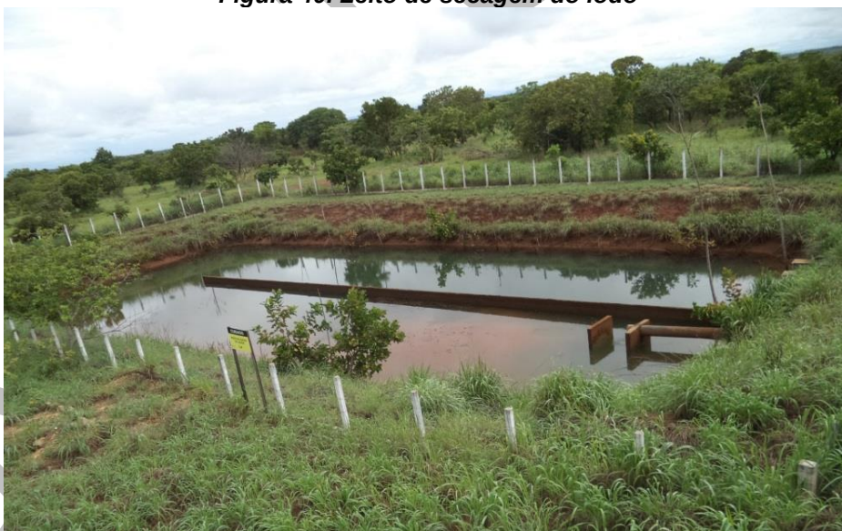
Figura 40. Leito de secagem do lodo
