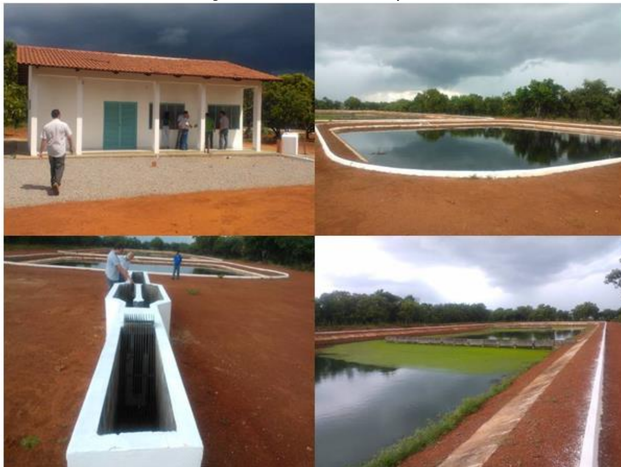
Figura 95. ETE – Nova Pinheirópolis
