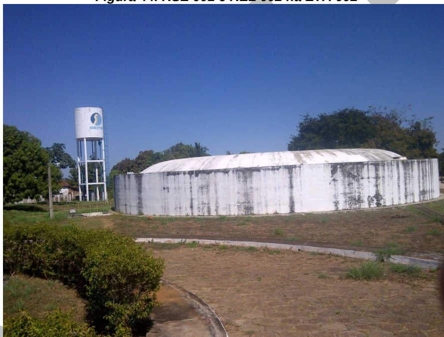
Figura 44. RSE 001 e REL 002 na ETA 002
