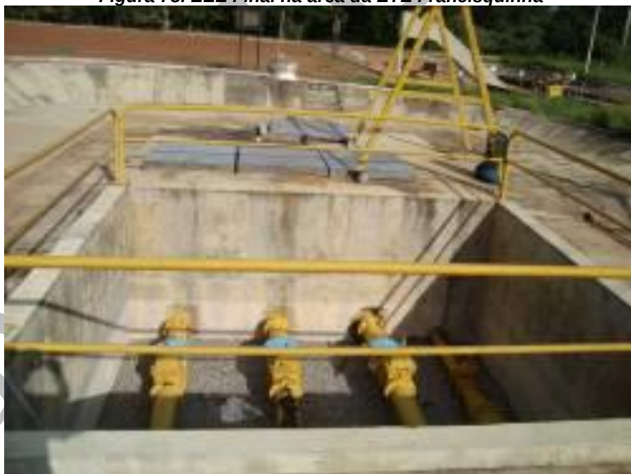
Figura 78. EEE Final na área da ETE Francisquinha
