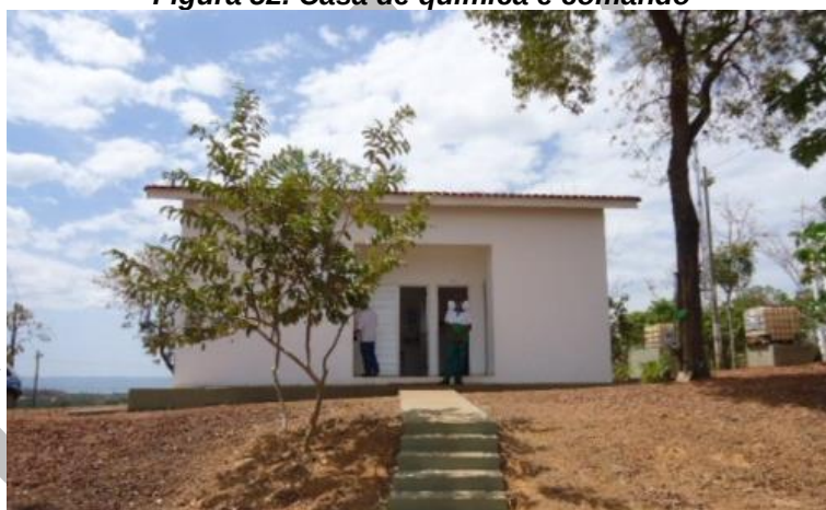
Figura 52. Casa de química e comando
