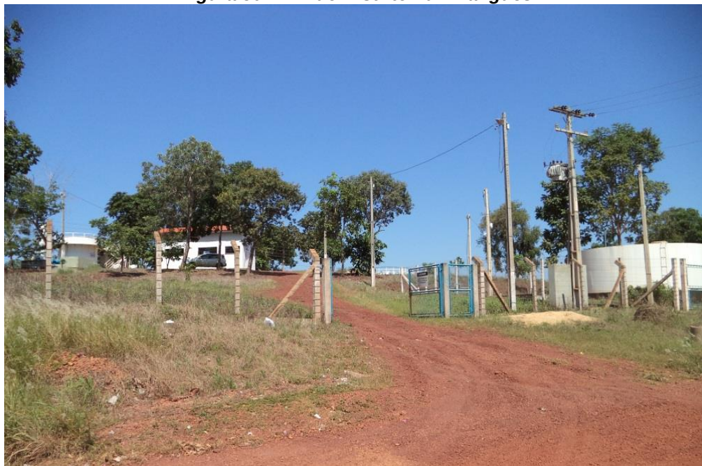
Figura 50. ETA do Distrito Luzimangues
