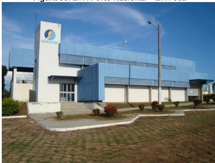
Figura 35. ETA Porto Nacional – ETA 002
