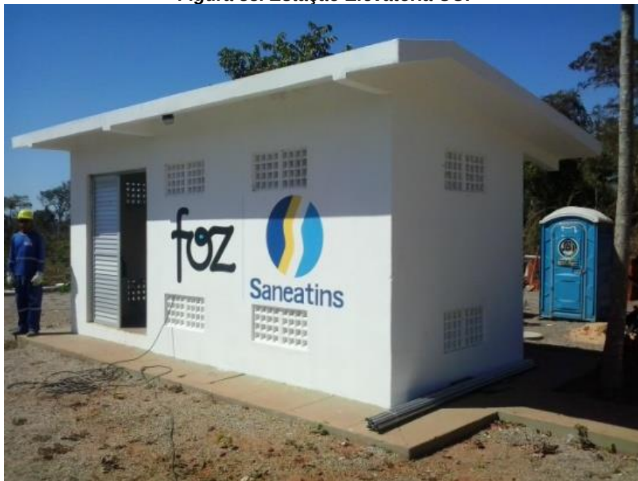
Figura 83. Estação Elevatória COI
