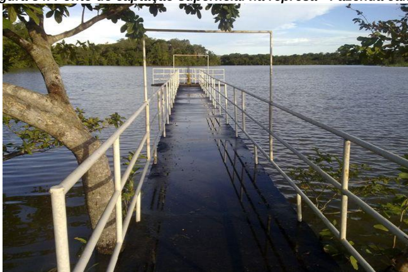
Figura 34. Ponto de captação superficial na represa - Fazenda Jaiara
