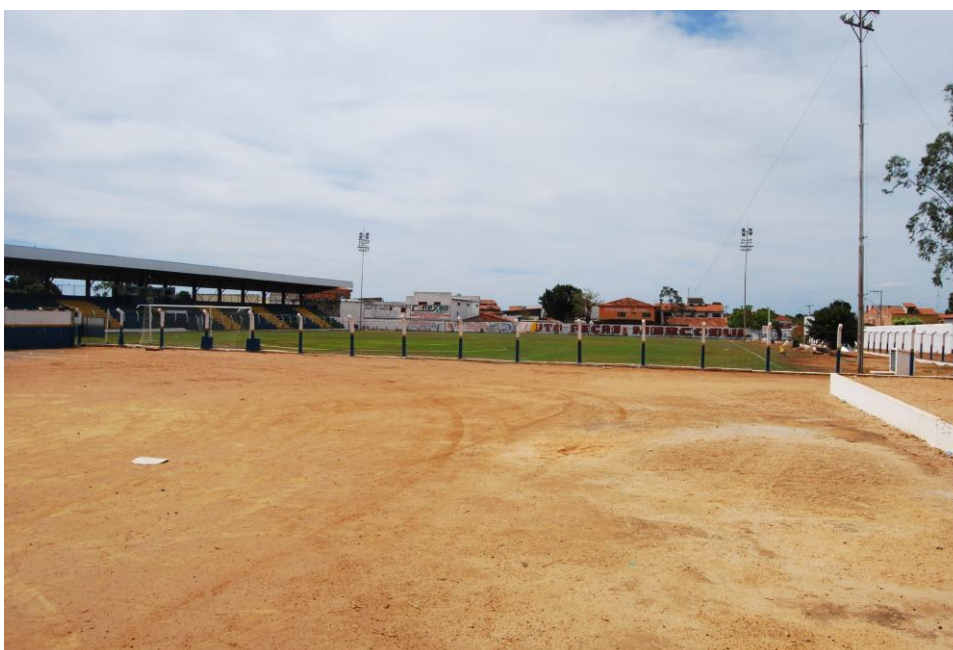
Foto 19: Estádio Municipal General Sampaio Correia
