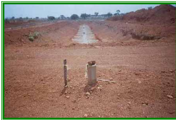
Foto 01: Vala do Aterro Sanitário.
