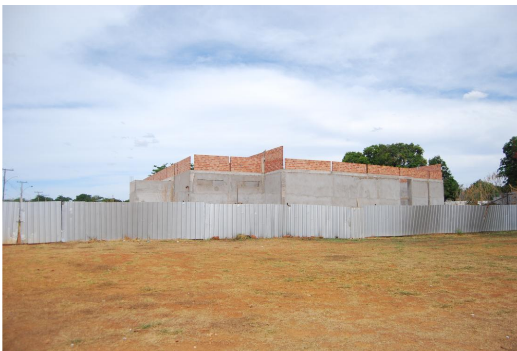
Foto 21: Centro de Convenções (em construção);
