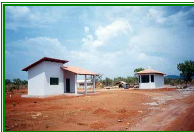
Foto 02: Guarita, escritório e casa de balança do Aterro Sanitário de Porto Nacional - TO
